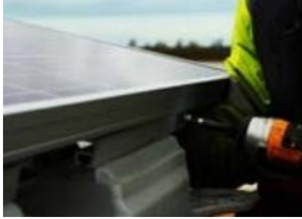
固定光伏组件
