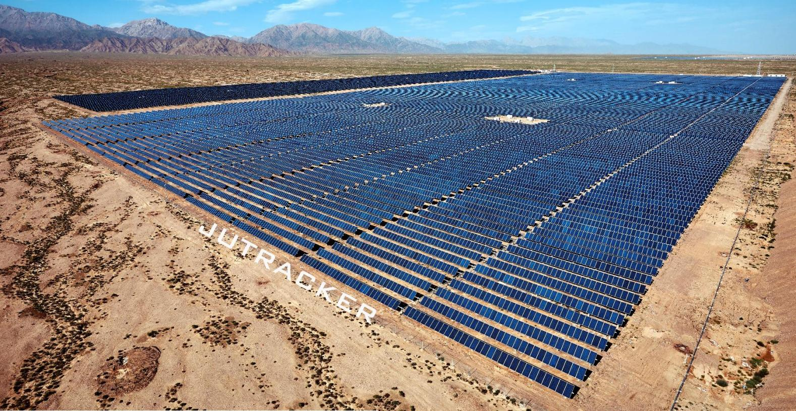
BiT-1P 单排竖装太阳能跟踪器优化了产品结构寿命和系统性能，帮助开发方和投资方的光伏发电站获得最大收益。BiT-1P跟踪器非常适合在复杂场地、强风和不规则边界的应用场景，采用回转机构作为驱动系统，系统配备阻尼器保证在极端天气系统的动态稳定性，提升系统的安全性。
